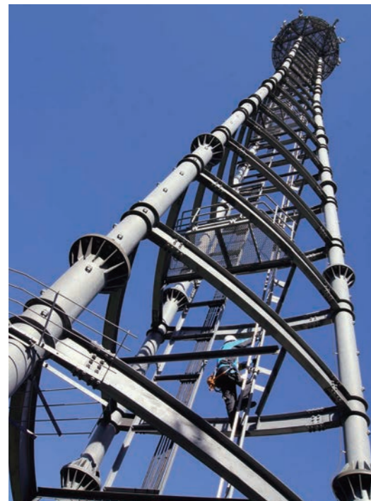
モバイル部 携帯電話基地局工事
