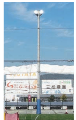
水銀灯型LED工事
