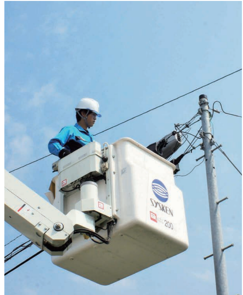
アクセス部 架空接続工事
