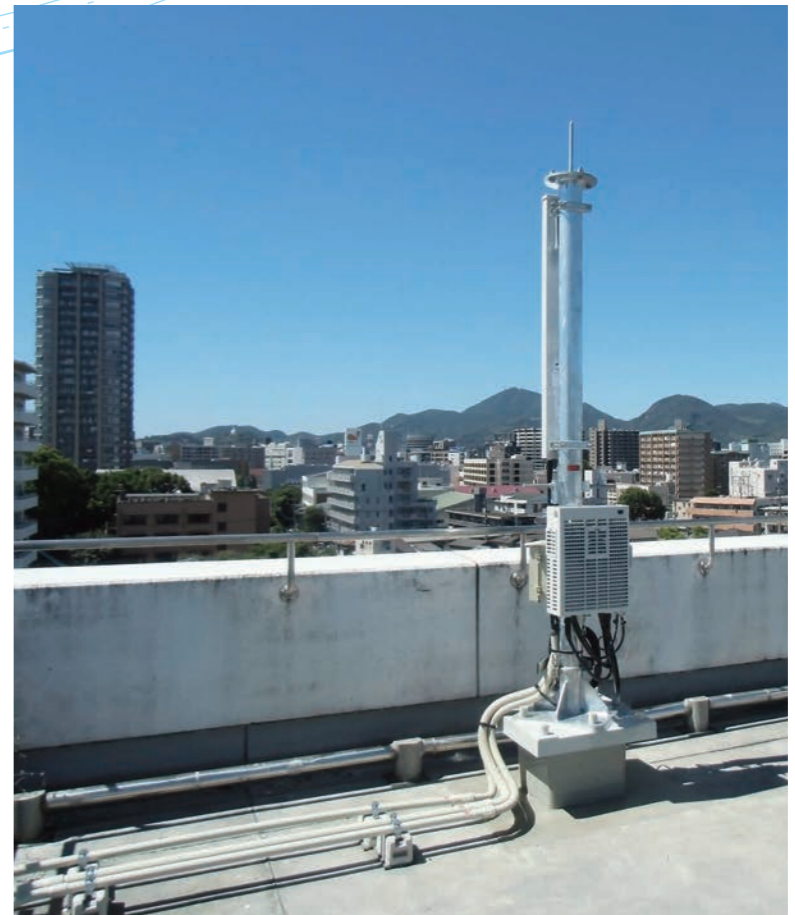
移動体基地局工事
