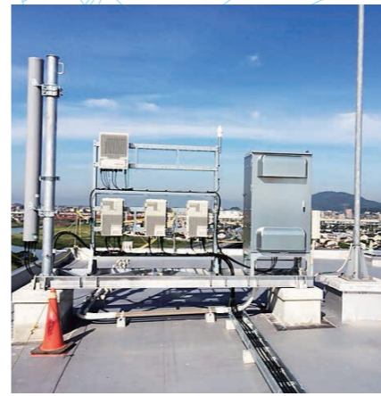
移動体基地局工事
