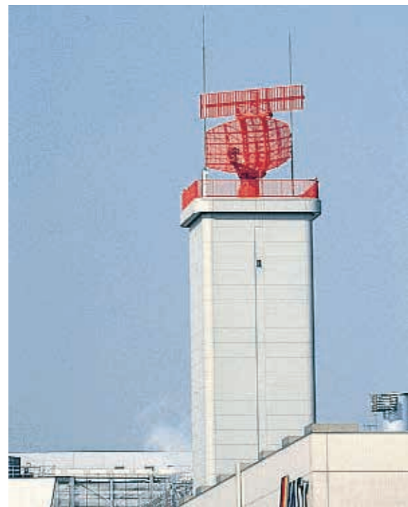
空港監視レーダー(ASR/SSR)
