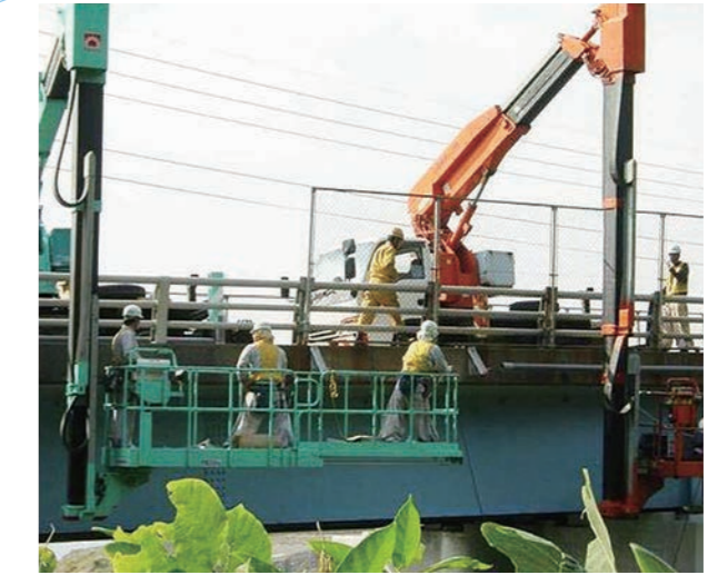
土木部 オーバーフェンス車両を使用し管路補修
