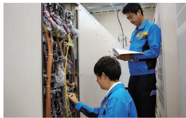
ネットワーク部 交換機の動作試験
