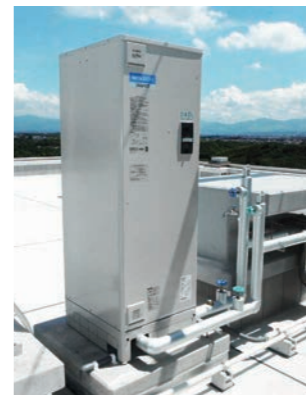
エコ給湯設備工事
