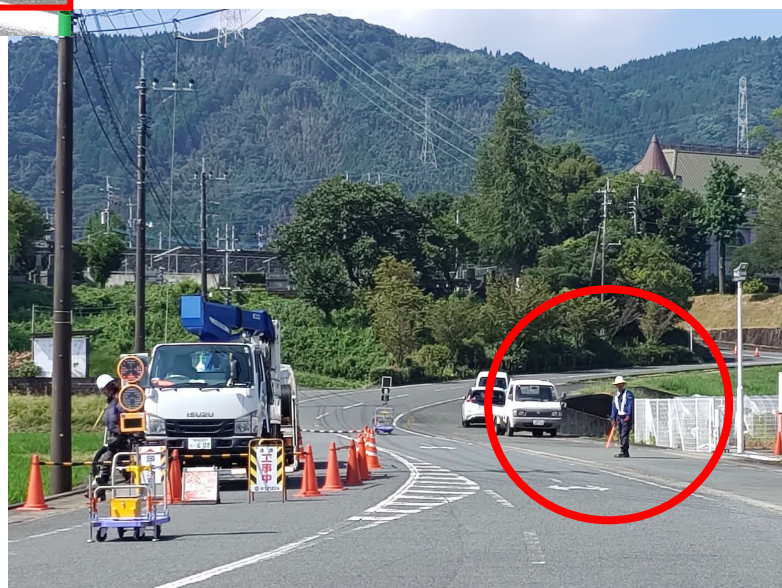
安全な位置での誘導 ※無線リモコンで操作
