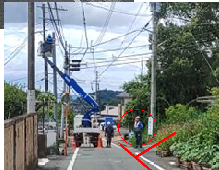
T路地の見通しのいい位置からの 誘導※無線リモコンで操作
