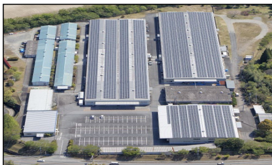
工場屋上(714Kw)航空写真
