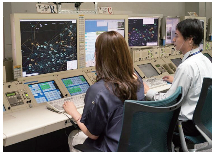
レーダ監視設備
