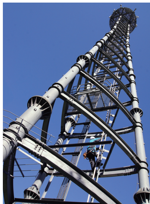
モバイル部 携帯電話基地局工事
