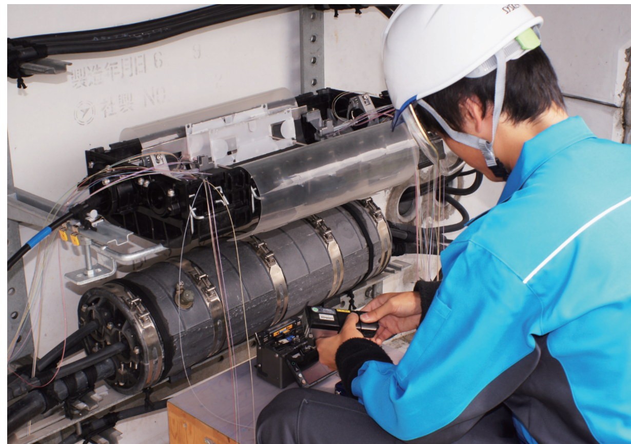
アクセス部 光ファイバケーブル接続
