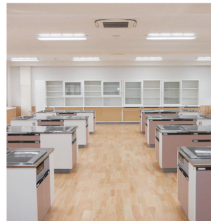
管設備工事（給排水工事）
