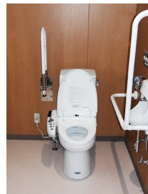
給排水設備工事
