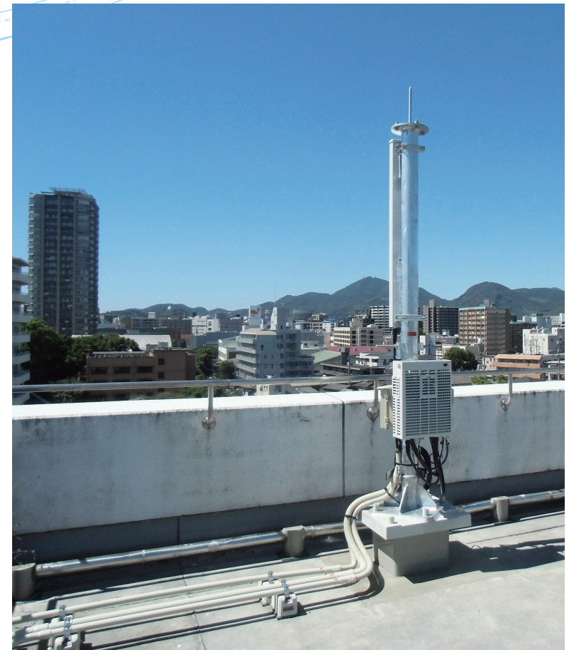
移動体基地局工事
