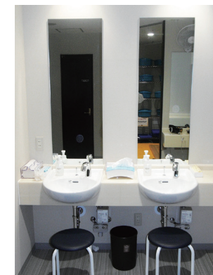
給排水設備工事
