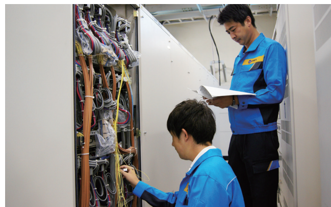
ネットワーク部 交換機の動作試験
