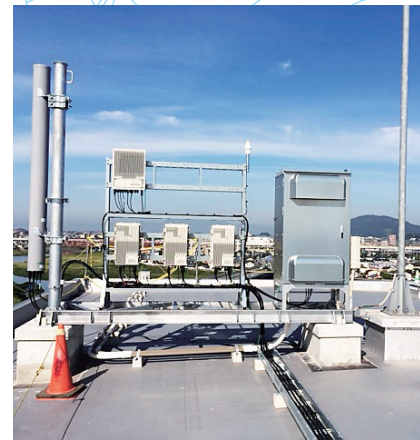
移動体基地局工事
