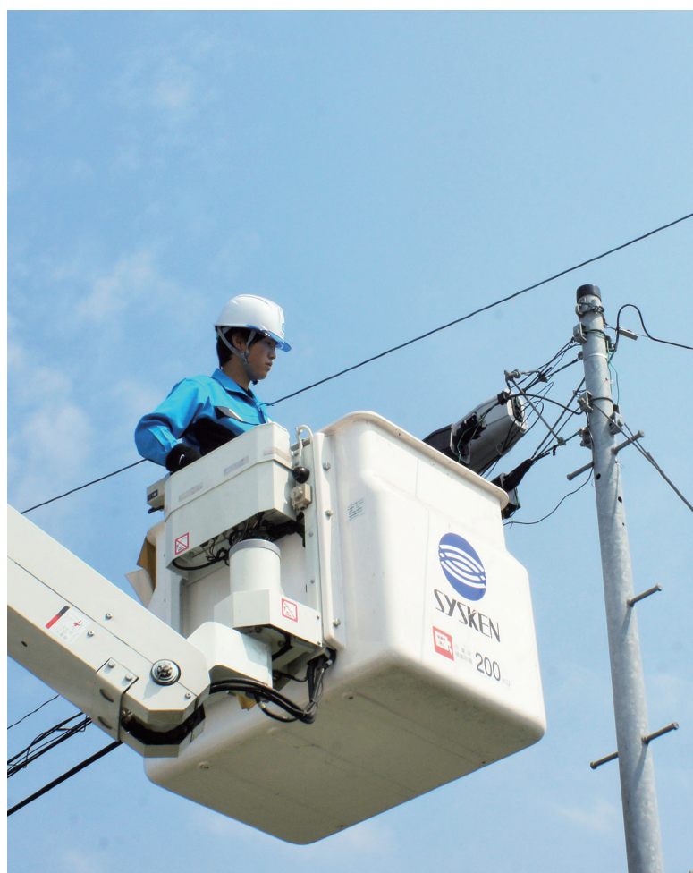
アクセス部 架空接続工事
