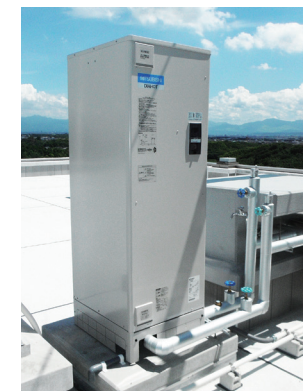
工口給湯設備工事
