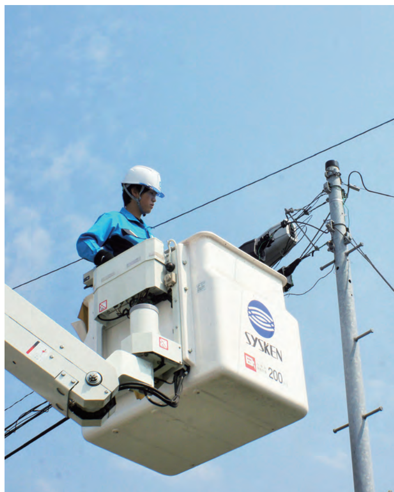
アクセス部 架空接続工事
