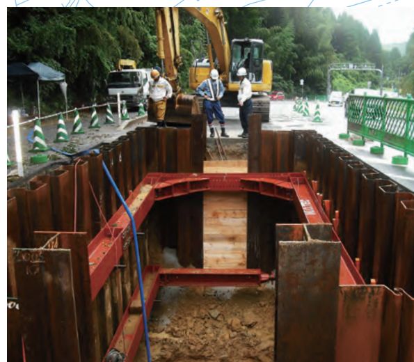
土木部 大型マンホール施工工事
