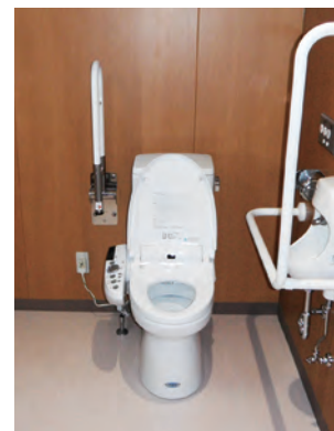
給排水設備工事
