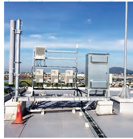
移動体基地局工事
