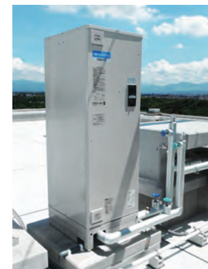
工口給湯設備工事
