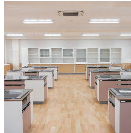
管設備工事(給排水工事)
