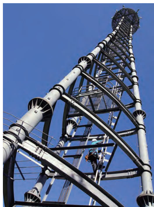
モバイル部 携帯電話基地局工事
