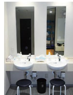
給排水設備工事
