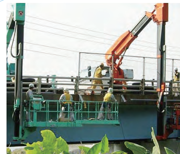
土木部 オーバーフェンス車両を使用し管路補修
