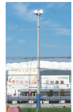
水銀灯型LED工事
