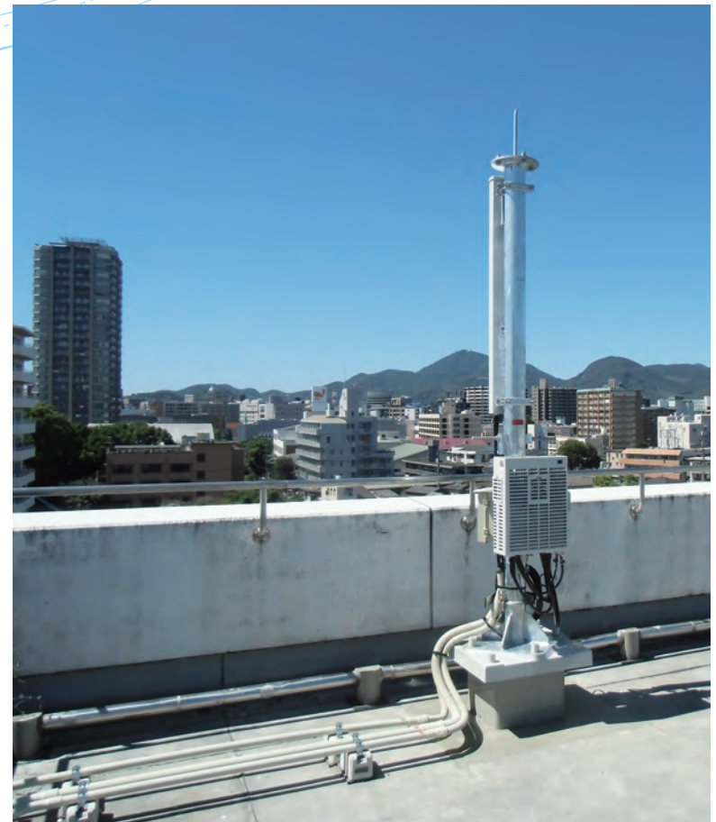
移動体基地局工事
