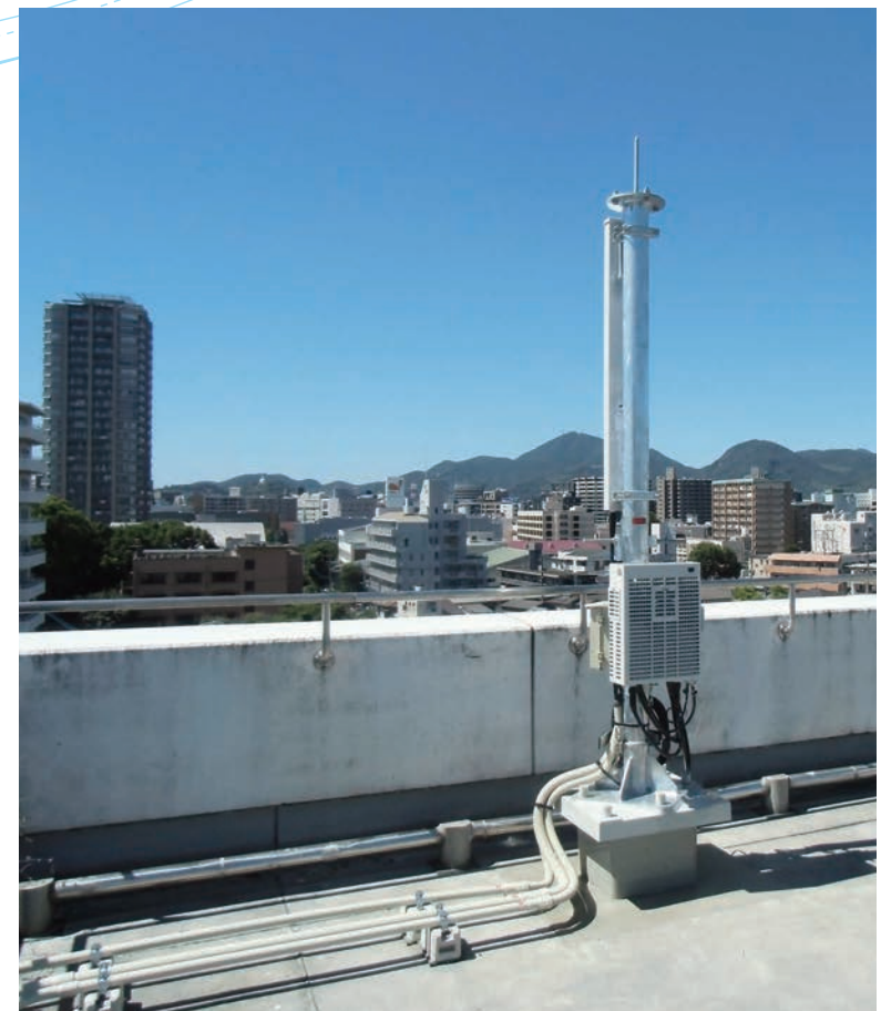
移動体基地局工事
