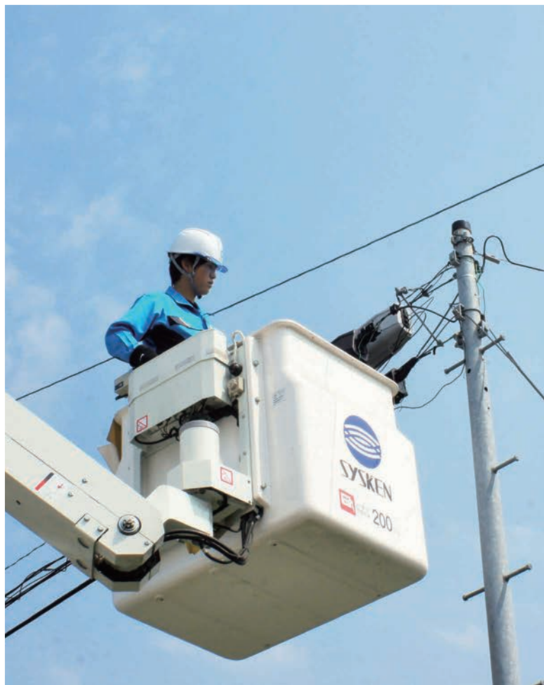
アクセス部 架空接続工事
