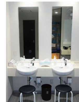
給排水設備工事
