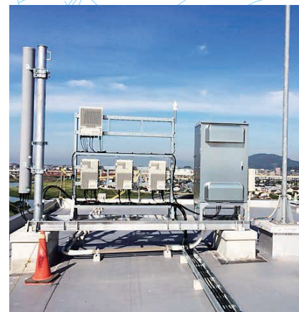
移動体基地局工事
