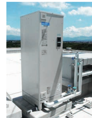
エコ給湯設備工事
