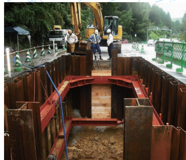
土木部 大型マンホール施工工事
