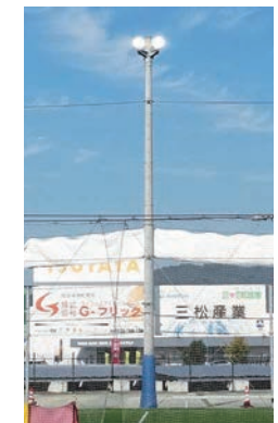
水銀灯型LED工事
