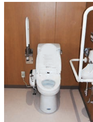
給排水設備工事
