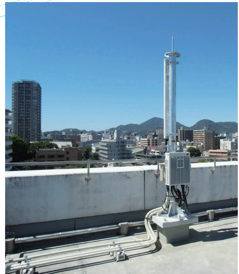
移動体基地局工事
