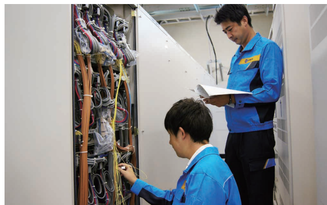
ネットワーク部 交換機の動作試験
