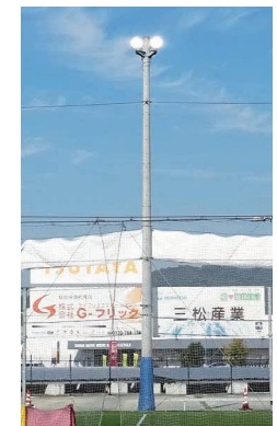
水銀灯型LED工事
