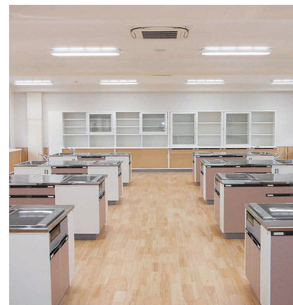
管設備工事（給排水工事）
