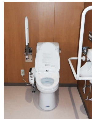
給排水設備工事
