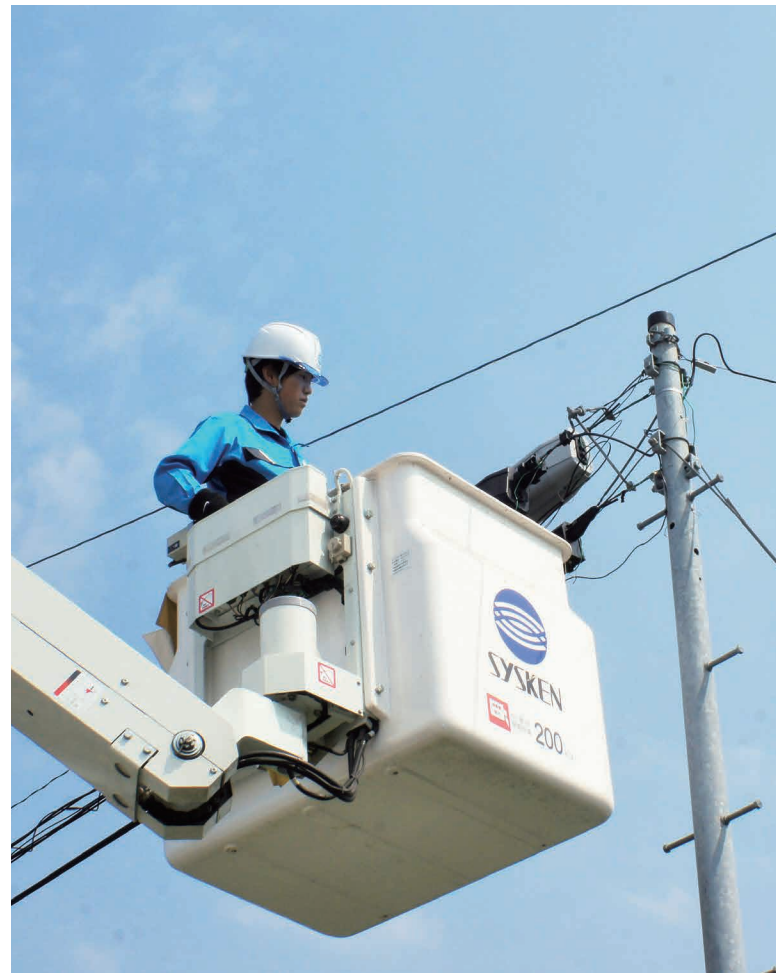
アクセス部 架空接続工事
