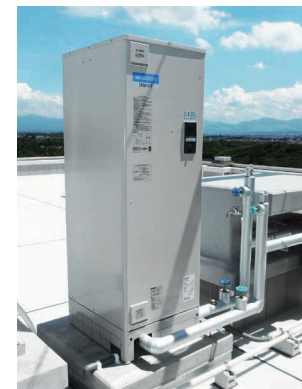
エコ給湯設備工事
