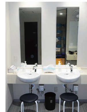
給排水設備工事
