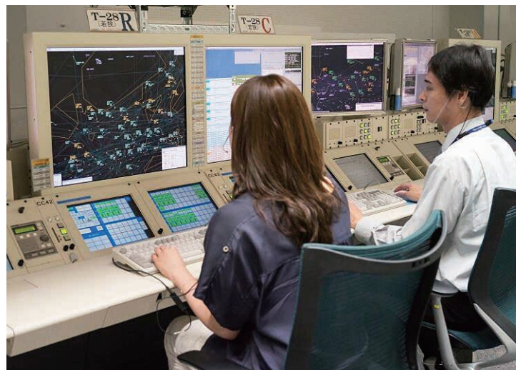
レーダ監視設備
