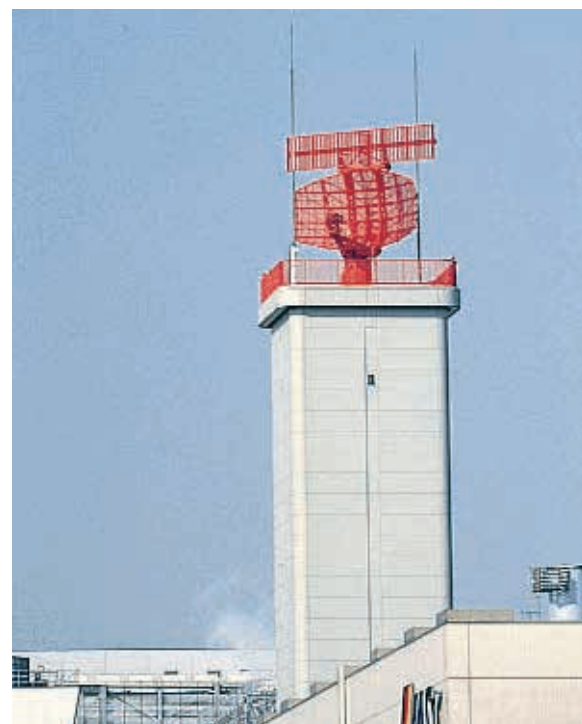
空港監視レーダー（ASR/SSR）
