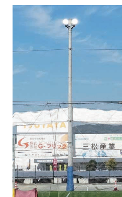
水銀灯型LED工事
