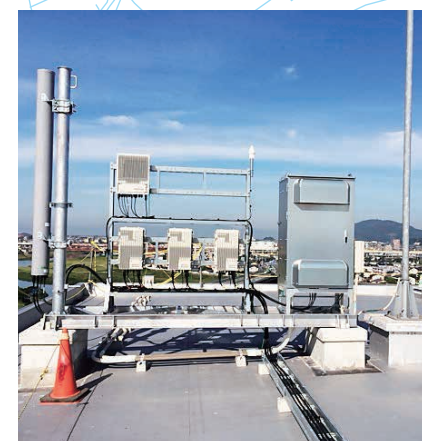
移動体基地局工事
