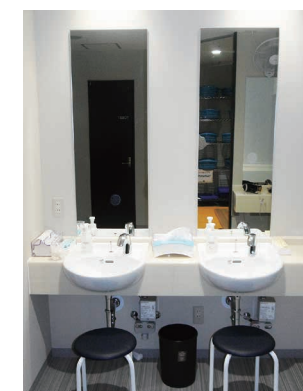
給排水設備工事
