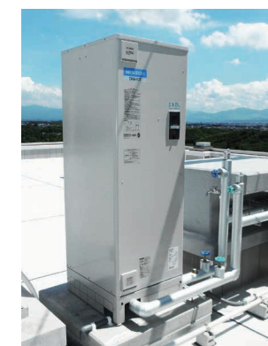
エコ給湯設備工事
