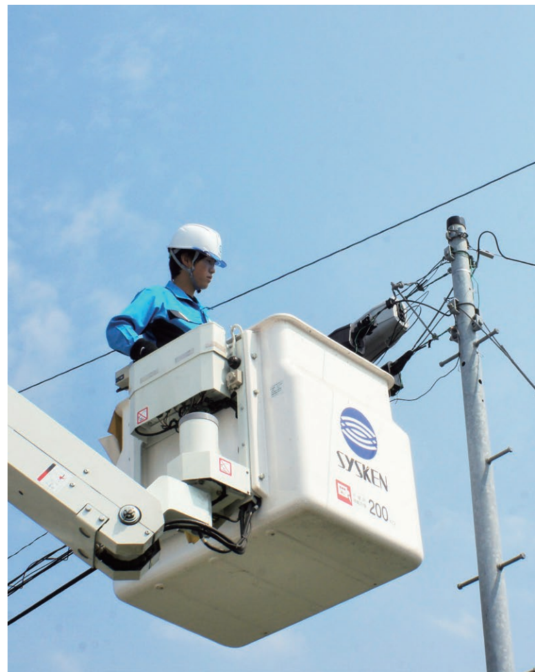
アクセス部 架空接続工事
