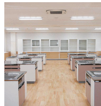
管設備工事（給排水工事）
