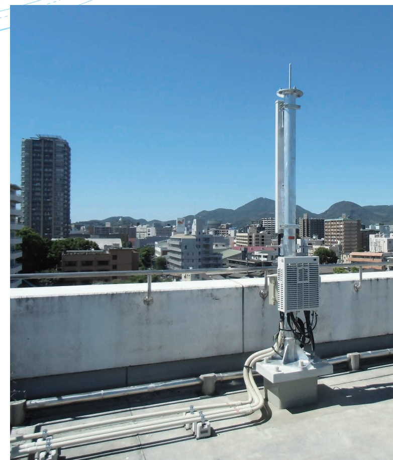
移動体基地局工事
