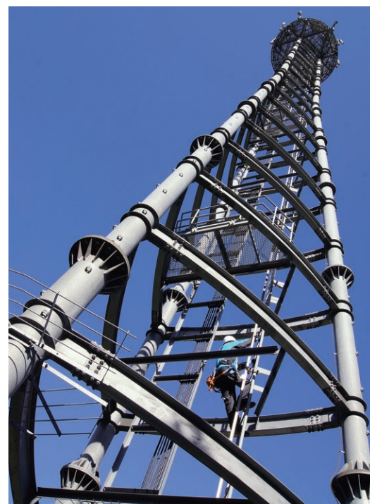
移動通信事業部 携帯電話基地局工事
