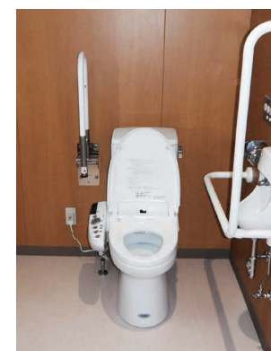
給排水設備工事
