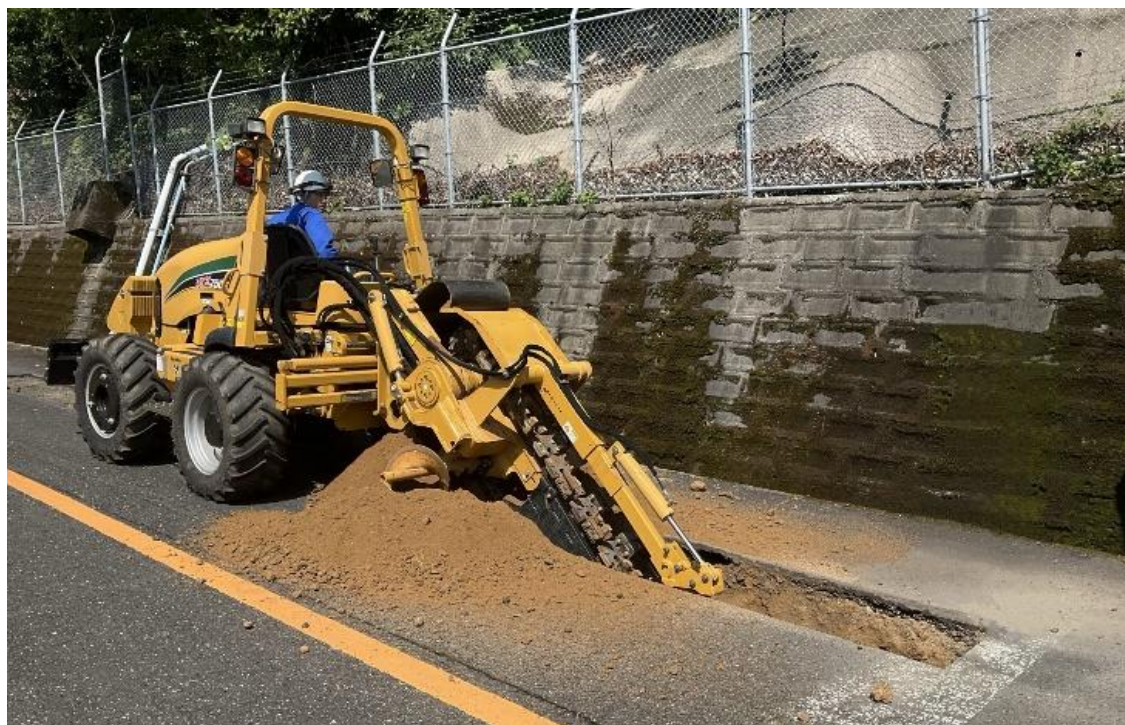
地中内中継伝送路設備
