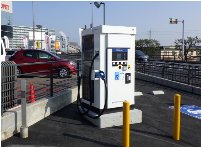
件名 熊本トヨペット(株)様 EV充電器設置工事 概要 急速充電タイプ
