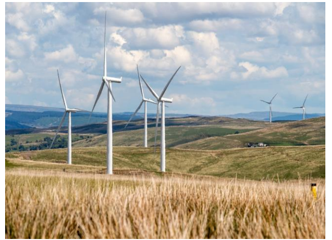
件名 風力発電設備設置に伴う自営線工事 概要 自営線工事
