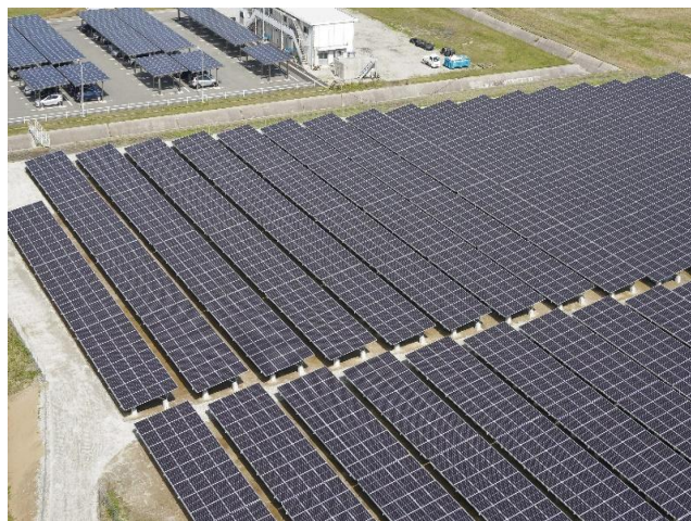
件名 ひびきエル・エヌ・ジー(株)様太陽光発電設備工事 概要 野立てタイプ/カーポート一体型タイプ カーポート137台分へ設置
